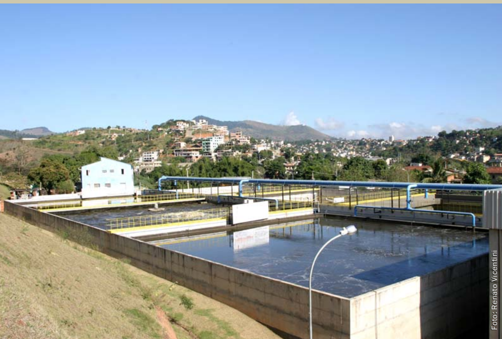
Tratamento de esgoto em Cachoeiro de Itapemirim
